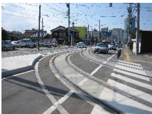
軌道区間 (於 電停「奥田中学校前」)
